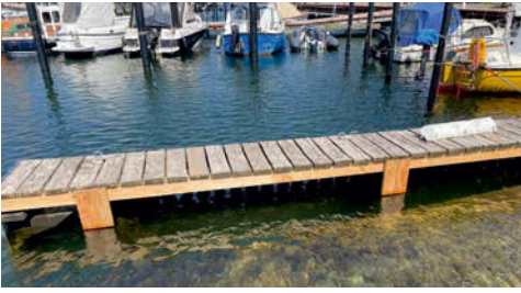
Der angebrachte Schutz vor den Stahlträgern
